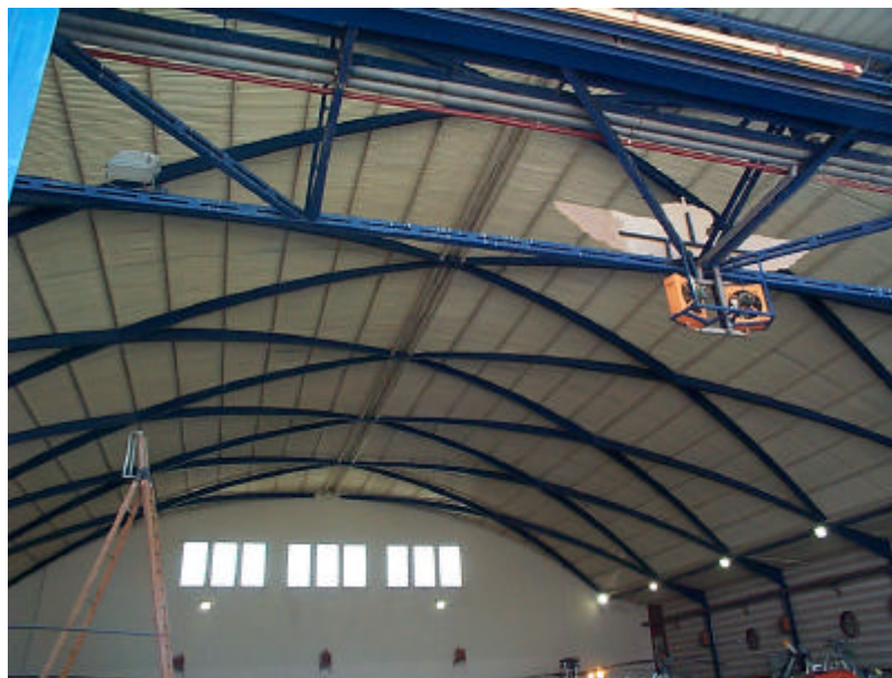
Figura 1.4. Hangar de Cuatro Vientos. Proyecto de E. Torroja (1949).
